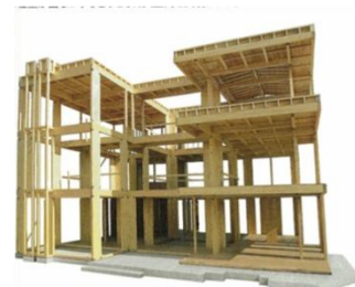
写真：事例SRの工
