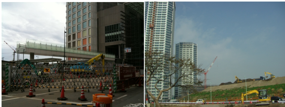
図 13 工事中の歩行者専用道路
