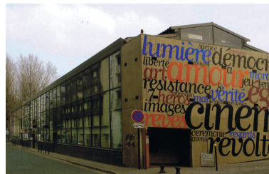
図4. 映画館MK2セーヌ河岸館 写真出典 「世界のコンバージョン建築」(小林克弘, 三田村哲哉, 橘高義典, 鳥海基樹 編集 鹿島出版社, 2008年4月, p178)
