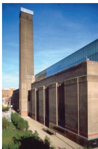
図1. Tate Modern(テート・モダン) 写真出典 http://www.tate.org.uk/modern/building/
