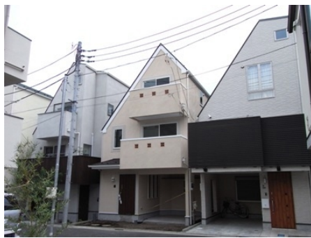
図 3.7 北側斜線によって斜めに切られた住宅
