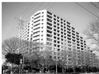
図 1.22 問題になった国立のマンション
