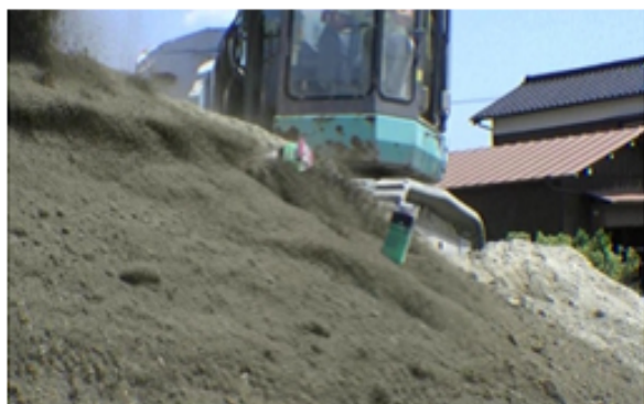
図 4.3 斜面上流から土砂を流す
