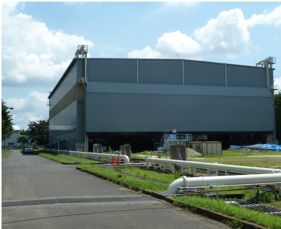
図 4.11 単独杭大型降雨実験施設 (防災科研)
