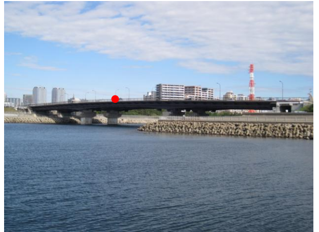
図 2.18 美浜大橋全景
