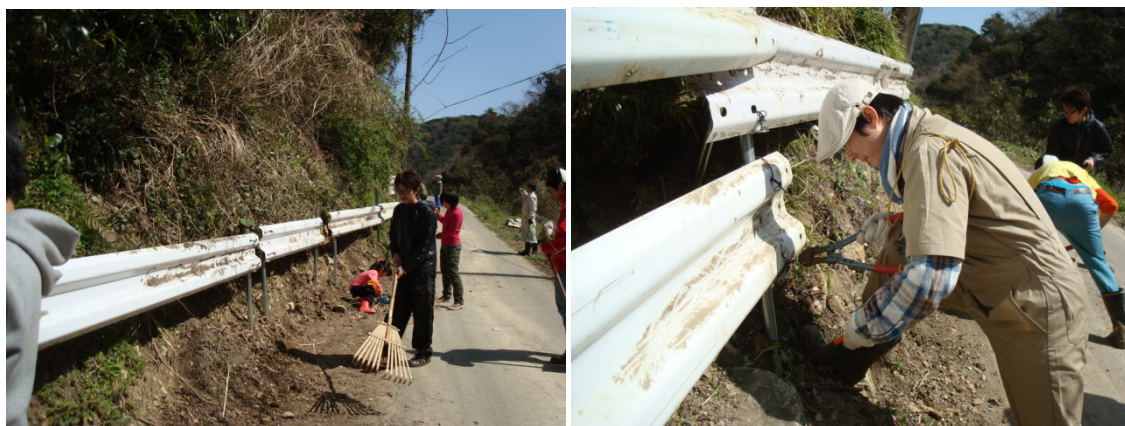
図 3-3 土砂崩れによるガードレールの復旧作業
