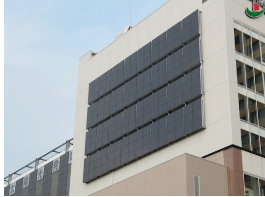
図 2-1-2-7 壁架台設置例
