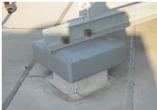
図 2-1-2-5 屋上架台の立ち上がり基礎
