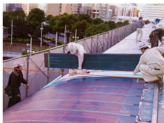
図 2-1-2-9 屋根材一体型の設置例
