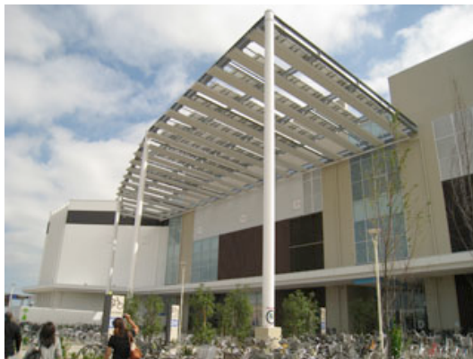
図 2-1-2-8 庇一体型 PV の設置例
