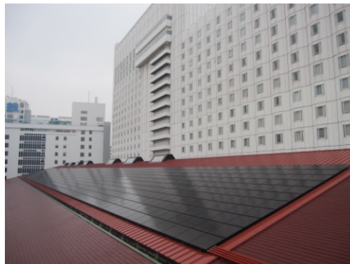
図 2-1-2-3 脚なしの屋根架台
