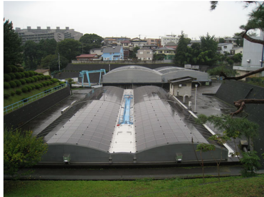
図 2-1-2-11 地上設置型の設置例
