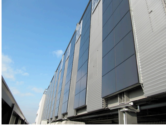
図 2-1-2-6 壁架台設置例
