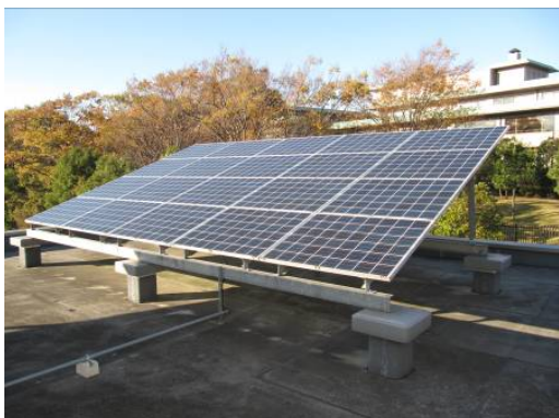
図 2-1-2-4 脚付きの屋上架台
