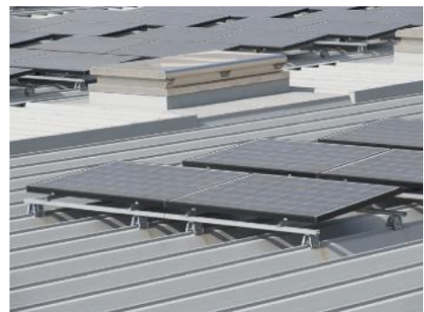
図3-2-1-3 ユニット化されたパネル 冷房負荷の削減も目指した。そのため、
