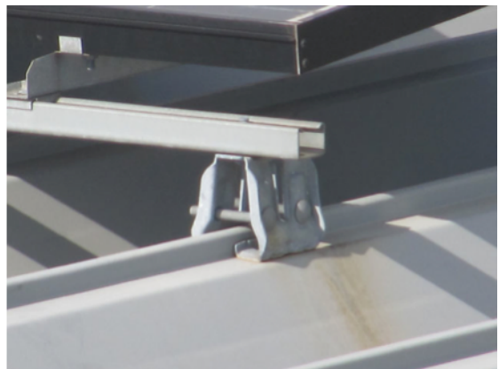
図3-2-1-2 架台と屋根の接合部
