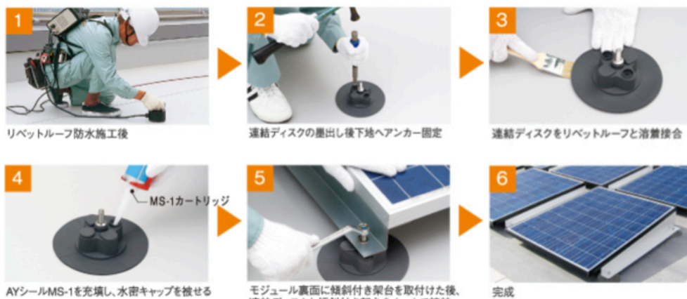
図 3-2-3-8 本事例と似た設置工法の例
