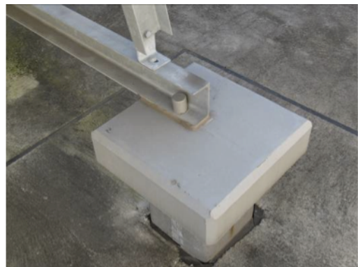
図 3-2-2-3 架台基礎の立ち上がり
