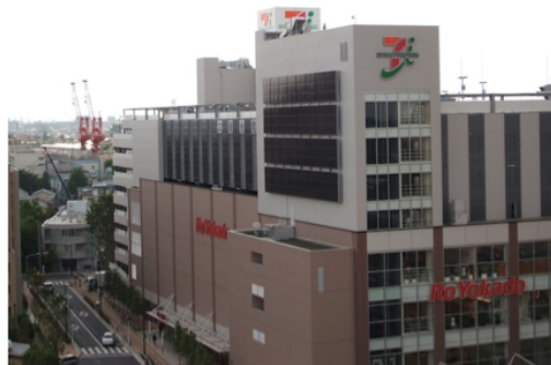
図 3-2-4-1 システム全景
