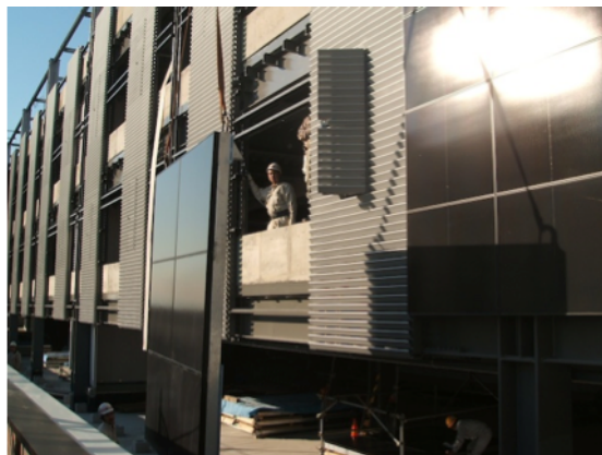
図 3-2-4-5 建材一体型 PV 設置工事
