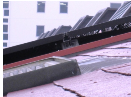
図3-2-1-5 スレート屋根と瓦棒
