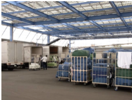
図 3-2-6-7 PV 屋根の下部
