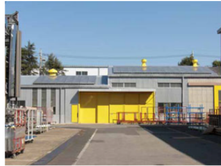
図3-2-1-13 システム全景
