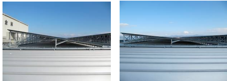
図3-2-1-11 架台の傾斜角の変化
