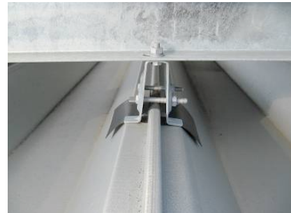
図3-2-1-10 折板屋根との接合
