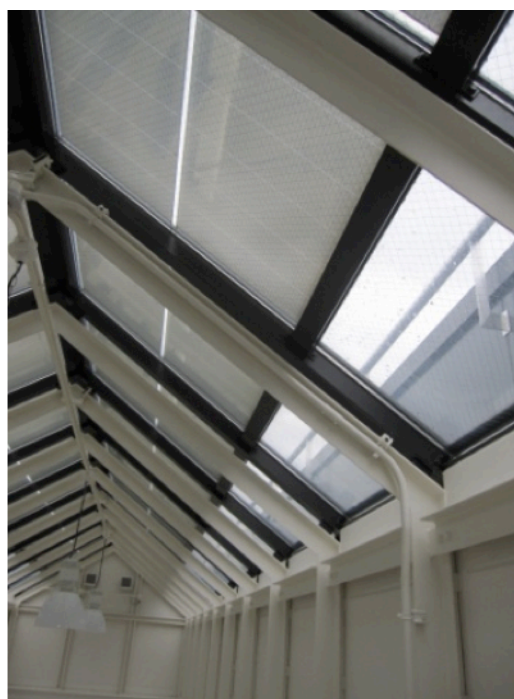
図 3-2-5-8 ガラス一体型の設置
