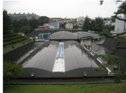
図 3-2-7-4 システム全景
