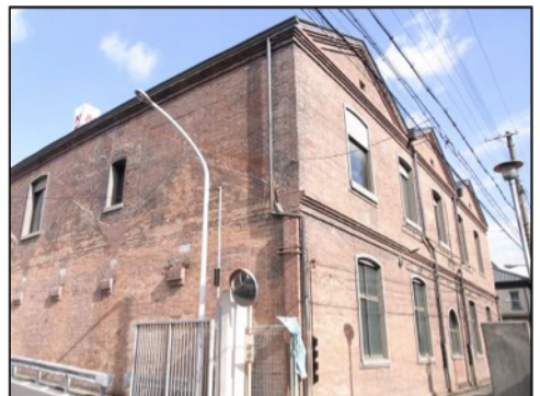
図 3-2-6-5 設置建物の外観
