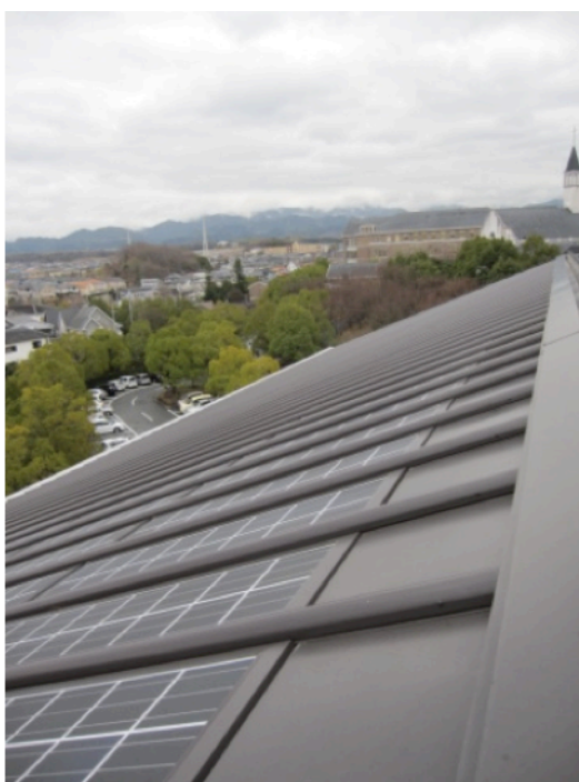
図 3-2-5-7 屋根材一体型の設置
