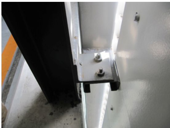
図 3-2-4-4 建材一体型 PV と建物の接合部
