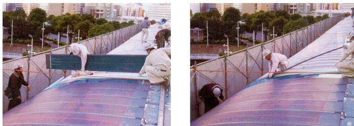
図 3-2-6-2 パネル設置の様子
