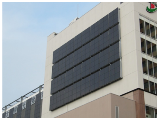
図 3-2-4-2 東側の壁架台設置
