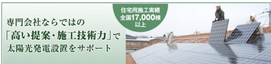
図 4-2-10-1. 施工の様子 NE 社の HP より引用
