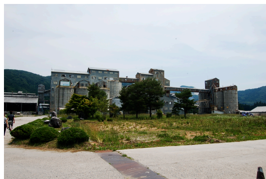
セメント工場跡地
