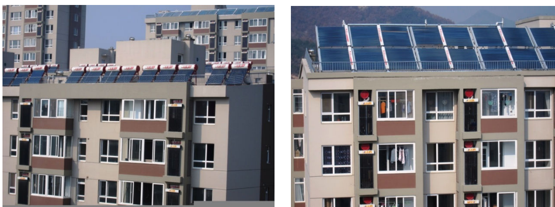
図4-1-26 事例D 2期 集熱器の設置 (左:その1 右:その2)
