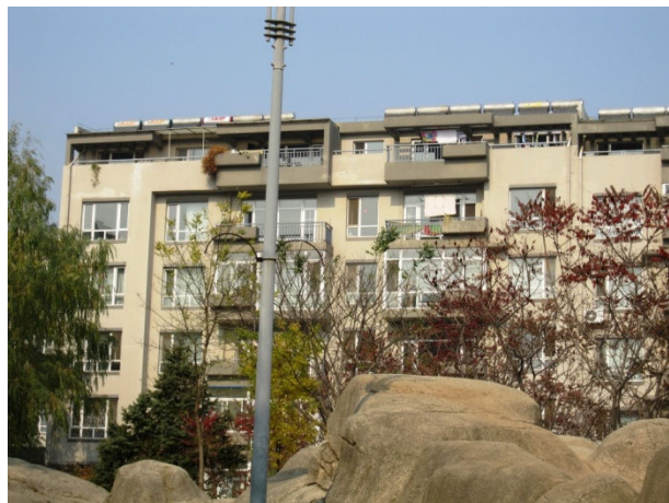
図 4-1-25 事例D1期 集熱器の外観
