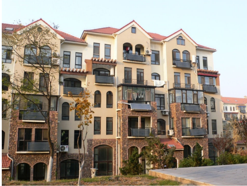
図4-1-23 移動された後の集熱器の外観
