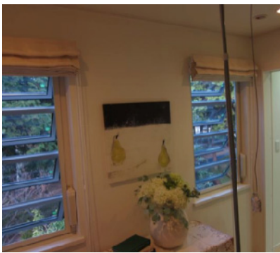
図 4.4.3 オーニング窓と自動制御スイッチ
