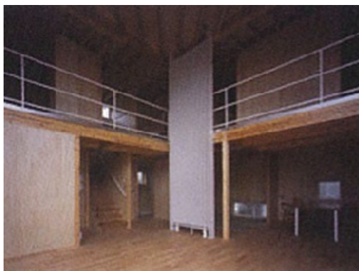
図 3.5.5 輻射冷暖房パネル（吹抜け奥）
