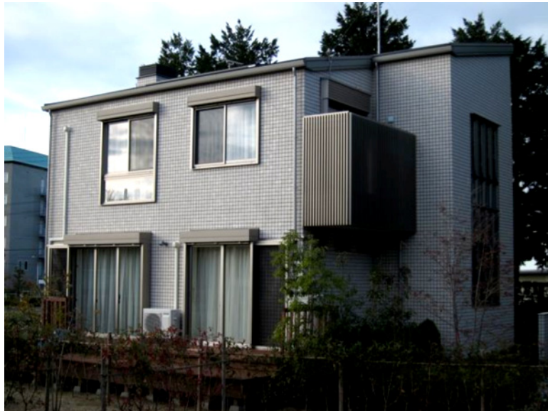
図 4.4.1 実験住宅 事例G 外観
