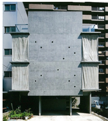
図 3,2,16 事例 A' 外観
