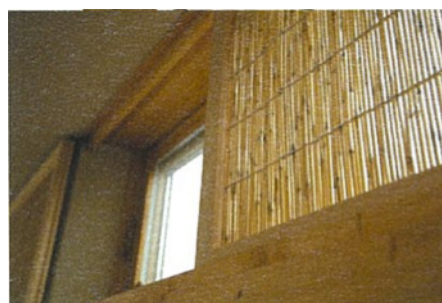
図 4.2.13 日射遮蔽のすだれ
