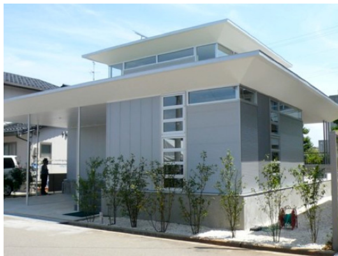
図 3,2,1 事例 A 外観
