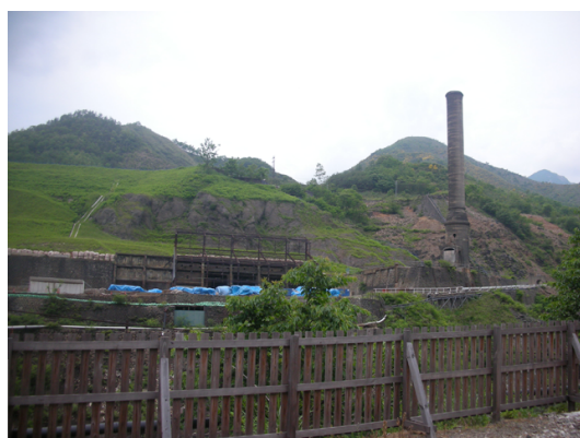
写真-3.30 煙突跡地
