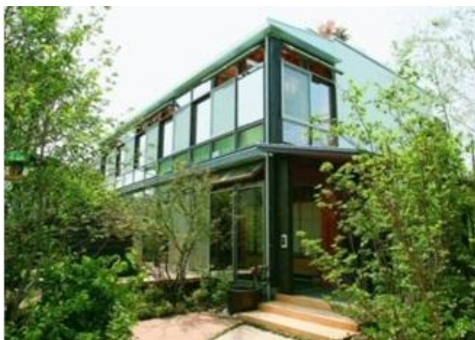
図4-12 写真：南東面ファサード
