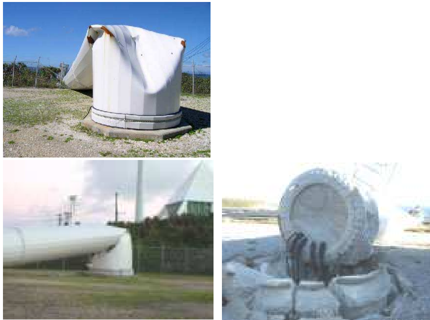
図 3-1 2 風車の倒壊事故例 [27]
