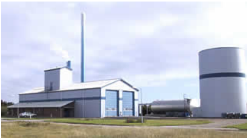
図 3-1 ガス化発電プラントの一例 (JFE エンジニアリング, 2007) (2007年12月より商業運転開始。年間約15,000tを処理可能。山形県村山市。 技術元はデンマークのBabcock&Wilcox Volund社)
