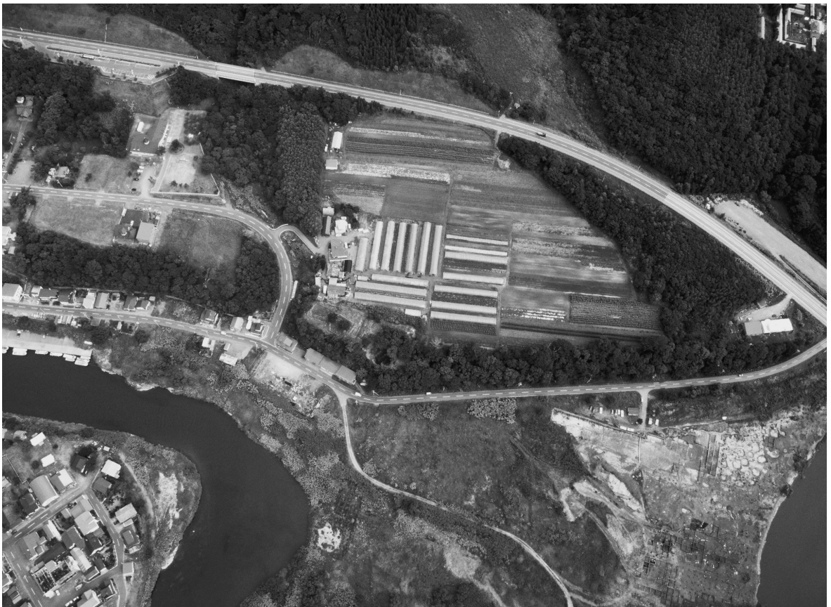
2 遠景（真上から、画面上が北西方向）
