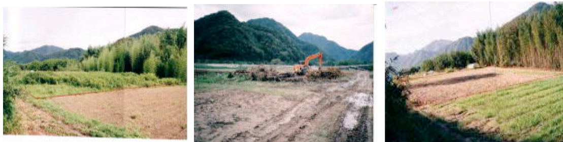
図 4-1-1 造成の様子（左：造成前の耕作放棄地、中：造成の様子、右：造成後の圃場）
