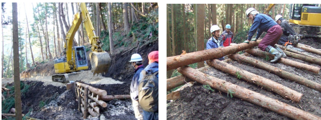
図 6-1-17 建設業者による路網の設置
