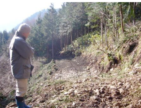
⑪設置した路網
