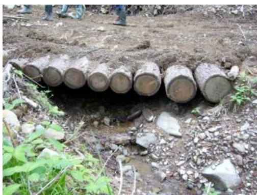
図 6-1-11 雨水への対策（左：横断水路、右：傾けられた路盤）
