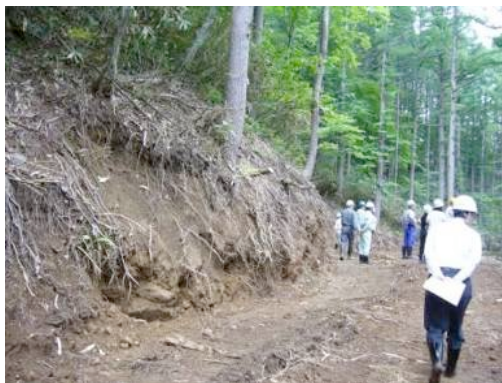
図 6-1-13 S 字状の作業路
