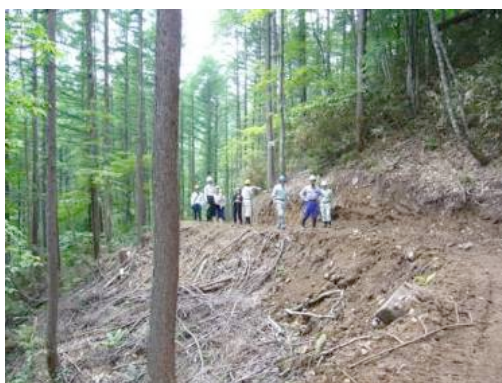
図 6-1-11 雨水への対策（左：横断水路、右：傾けられた路盤）
