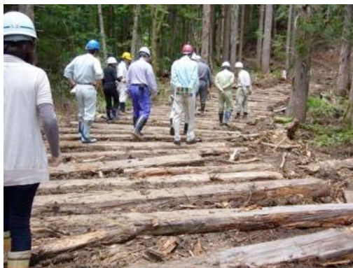
図 6-1-12 丸太を敷いた作業路
