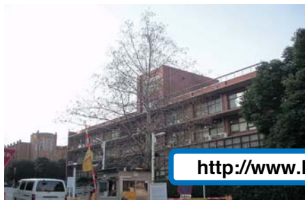
医学図書館外観(耐震改修工事前)
