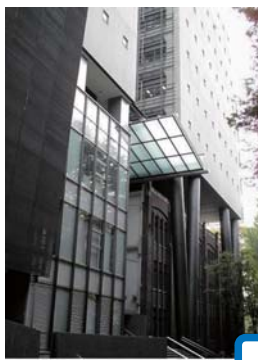
工2号館図書室外観
