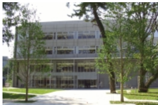
駒場図書館外観
