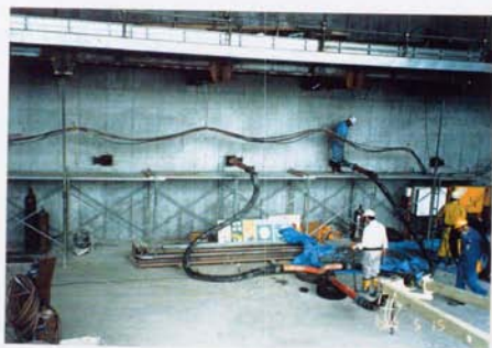
写真-6.3.2 分岐管工法による圧入充填状況
