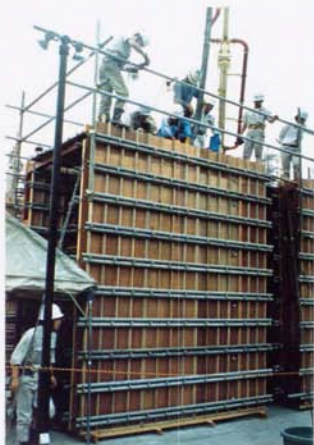
写真-4.2.2 ブーム付きコンクリートポンプ車による打設状況
