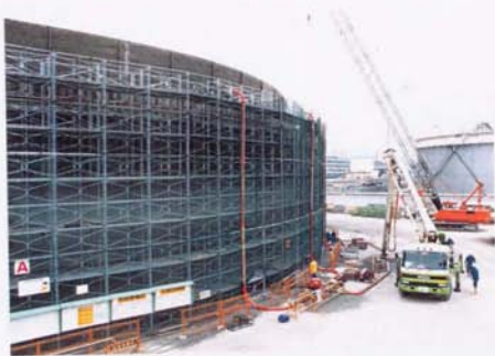
分岐管工法による充填状況
