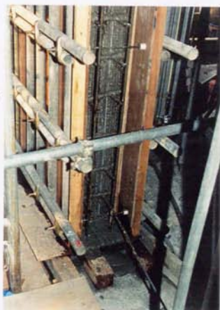
写真-6.5.2 ラス止めによる打ち止め状況
