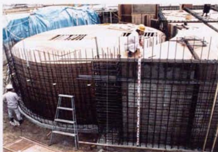
写真-5.7.1 壁部材の配筋状況
