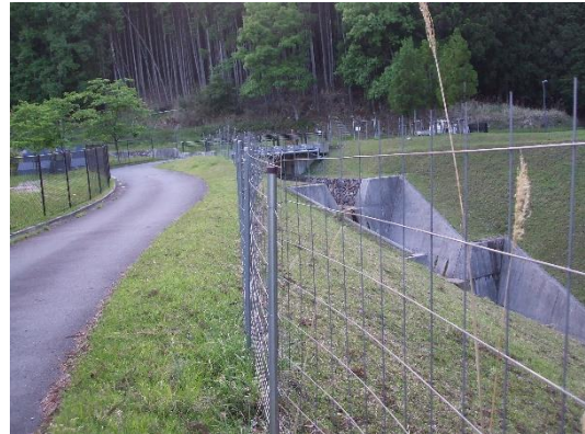
② 集落と山縁に設置された状況
