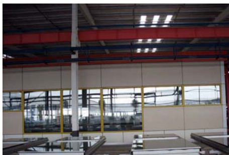
図 7-6 シーリング材を注入する設備の部屋の外観 (撮影: 筆者)
