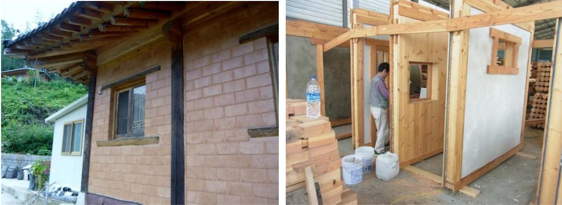
写真 4.4.3 煉瓦壁（左）、土壁パネル（右）
