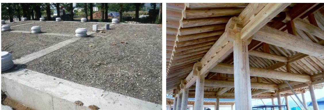
写真 4.4.1 布基礎（左）、構造材組立状況（右）
