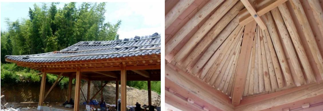
写真 4.4.2 屋根施工状況（左）、隅部垂木施工状況（右）
