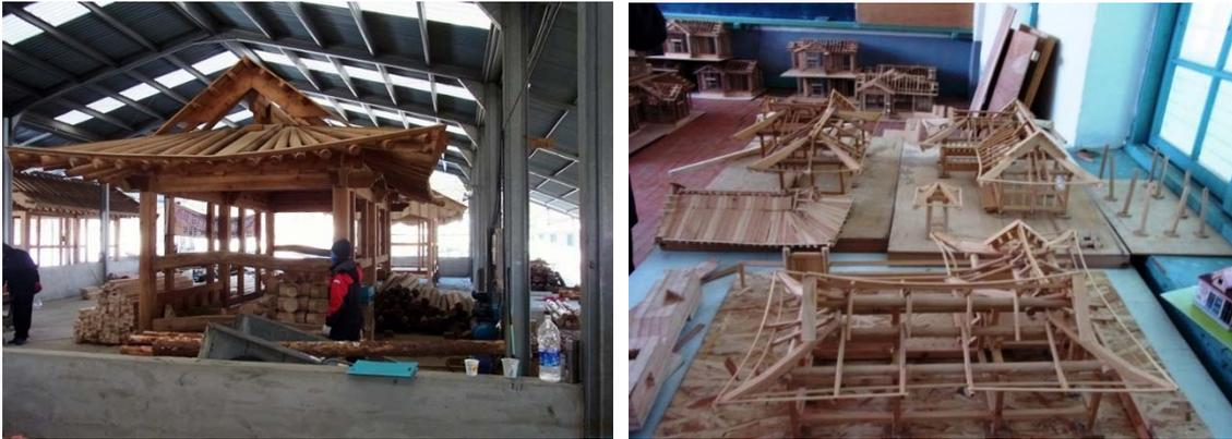
写真 3.4.5 実習で製作する軸組（左）、軸組模型（右）
