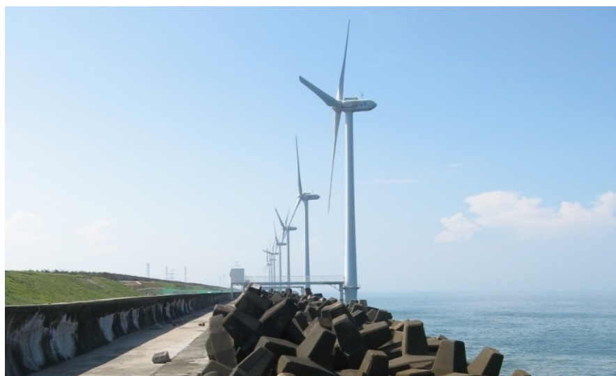
図 6-1 観測の対象としたウィンド・パワーかみす洋上風力発電所（茨城県神栖市南浜地先）
