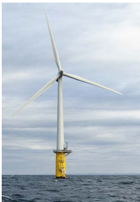
図 1-9 ノルウェーの Statoil 社による世界初の浮体式洋上風力発電実証実験機 Hywind[18]
