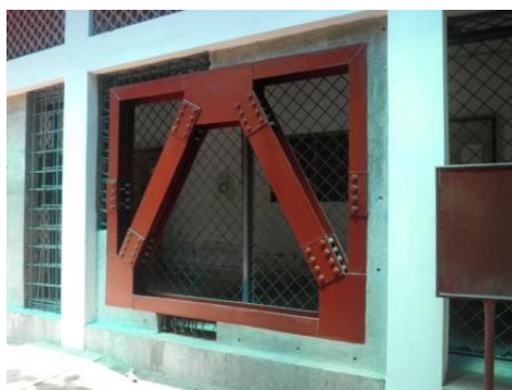
図 41 鉄骨ブレース補強
