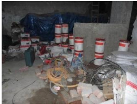
図 104 資材置場 (事例 5)
