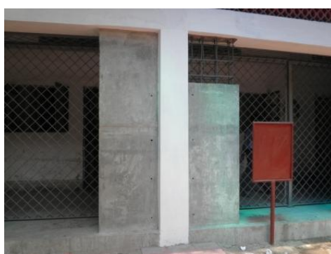
図 39 RC 袖壁補強
