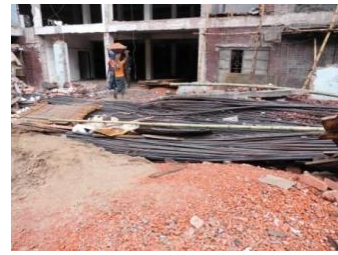
図 103 資材置場 (事例 3)
