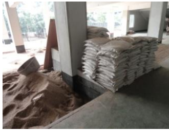
図 101 資材置場 (事例 1)
