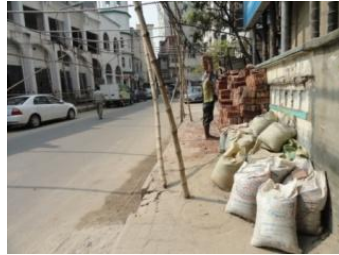
図 102 資材置場 (事例 2)
