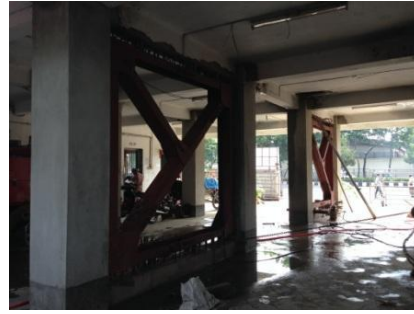
図 33 パイロットプロジェクトの鉄骨補強
