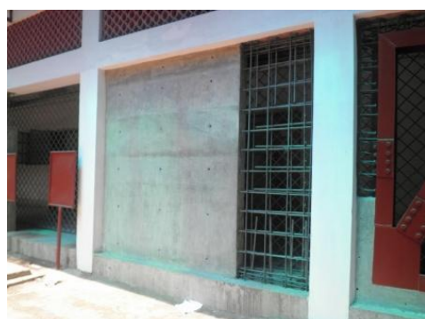
図 40 RC 耐力壁補強
