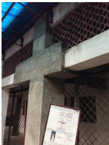
図 44 柱梁接合部の補強
