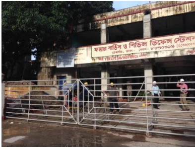
図 32 パイロットプロジェクト現場
