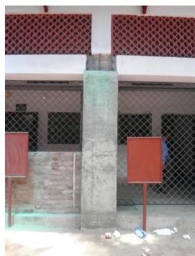
図 38 既存柱コンクリート補強
