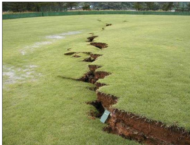
図-1.9 被害状況（斜面崩壊・亀裂） 6)
