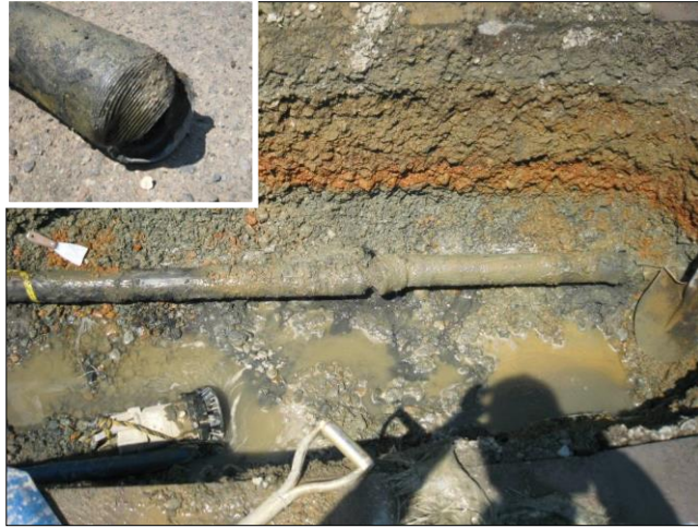
図-1.15 低圧ねじ管の被害状況 9)
