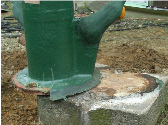
図-1.14 基礎アンカーボルトの破損状況（刈羽供給所ガスホルダー） 9)
