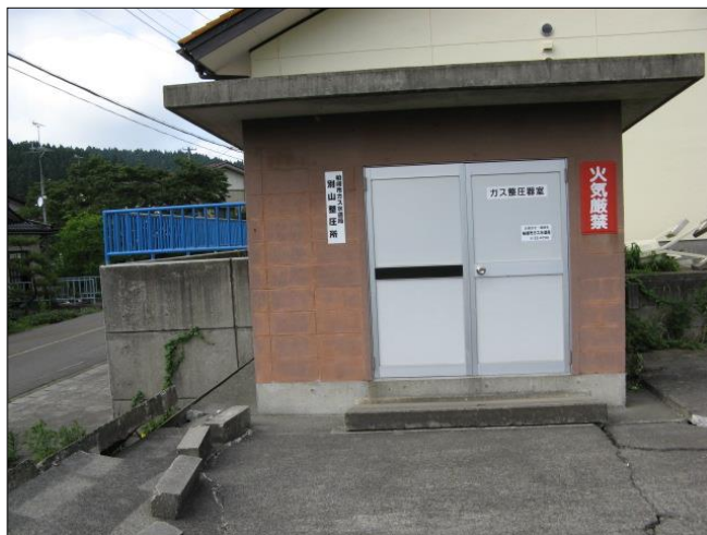
図-1.16 コンクリート基礎の破損状況 9)
