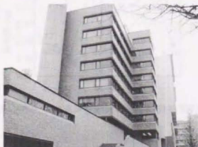
図 2-5-6. 東京大学工学部 11 号館
