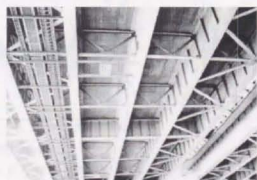
図 5-2-2. 鋼桁およびRC床版
