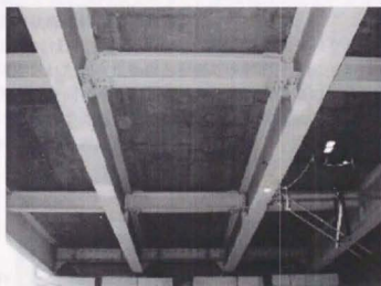
図 5-4-4. 鋼桁およびRC床版
