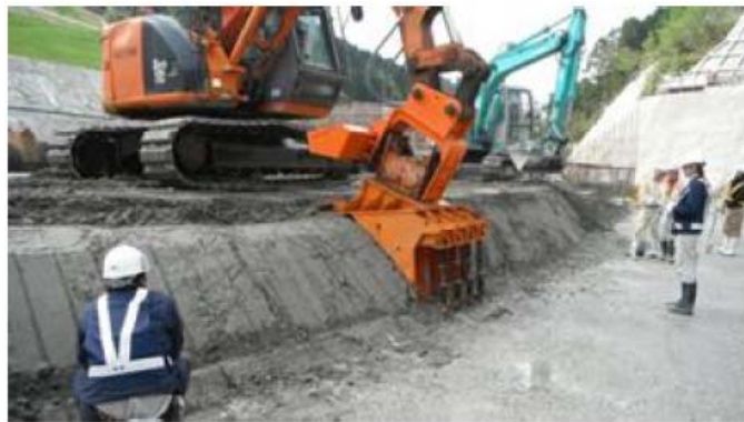
写真－2.11.5 二面拘束型専用機による端部法面締固め状況
