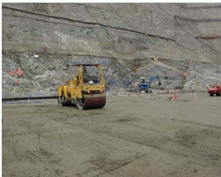
写真－3.3.11 章動ローラによる転圧状況（滝沢ダム）
