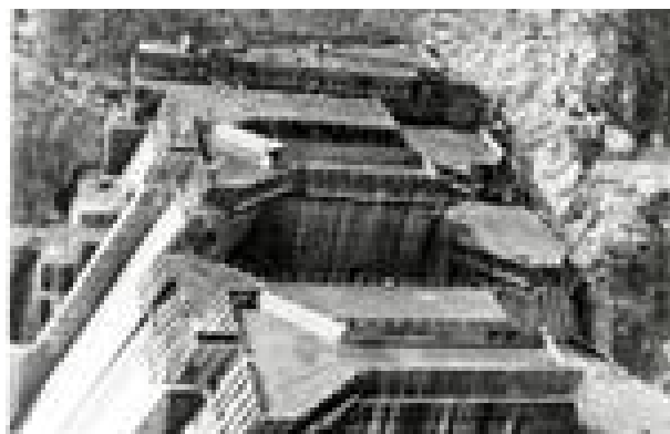
図－3.2.4 中空重力式コンクリートダムの概要 写真－3.2.2 中空重力式コンクリートダム （内の倉ダム） 2)
