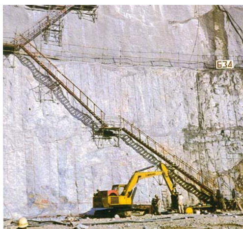
写真－2.2.2 川治ダムプレスプリット工法
