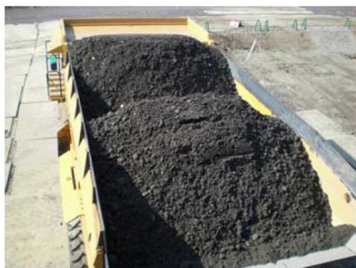
写真-2.12.4 55t 級重ダンプトラックへのCSG積荷状況
