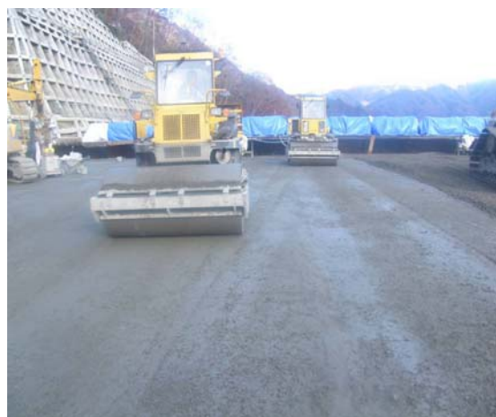
写真－3.3.4 RCD 用コンクリートの敷均し・締固めの状況（湯西川ダム）
