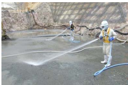
写真-2.10.7 打設面グリーンカット処理状況
