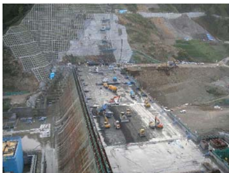
徳富ダムにおけるダンプトラック直送方式
