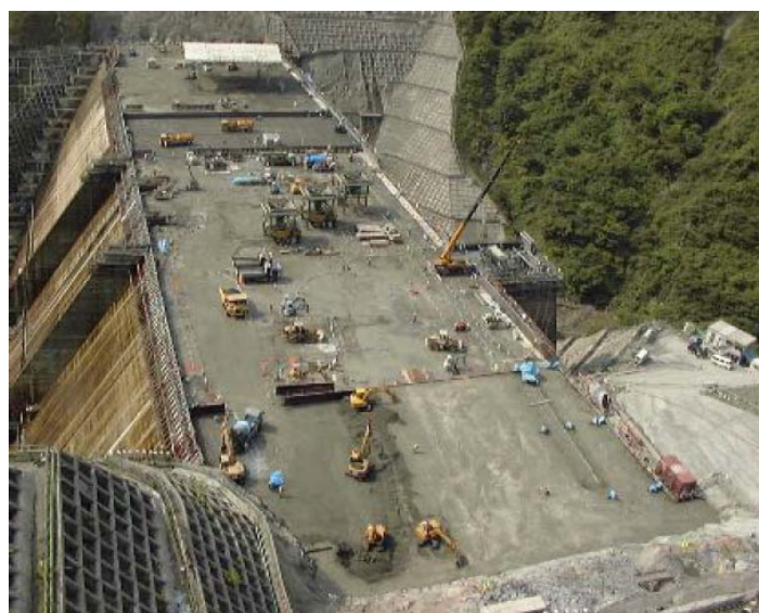
写真－3. 2. 8 拡張レヤー工法による施工中の滝沢ダム
