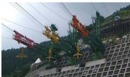
滝沢ダムにおける循環バケット（写真 上）と ケーブルクレーン（３機、写真 下）
