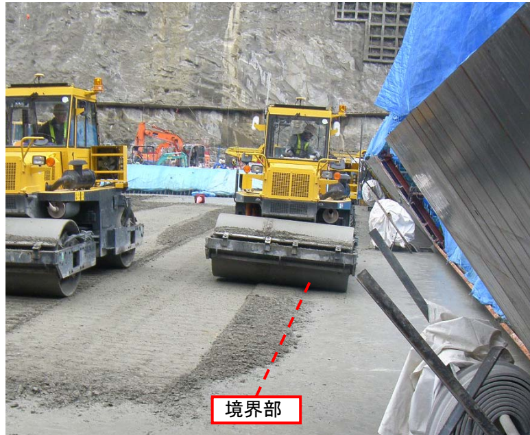
写真－3.3.13 境界部の振動ローラによる締固め状況（湯西川ダム）
