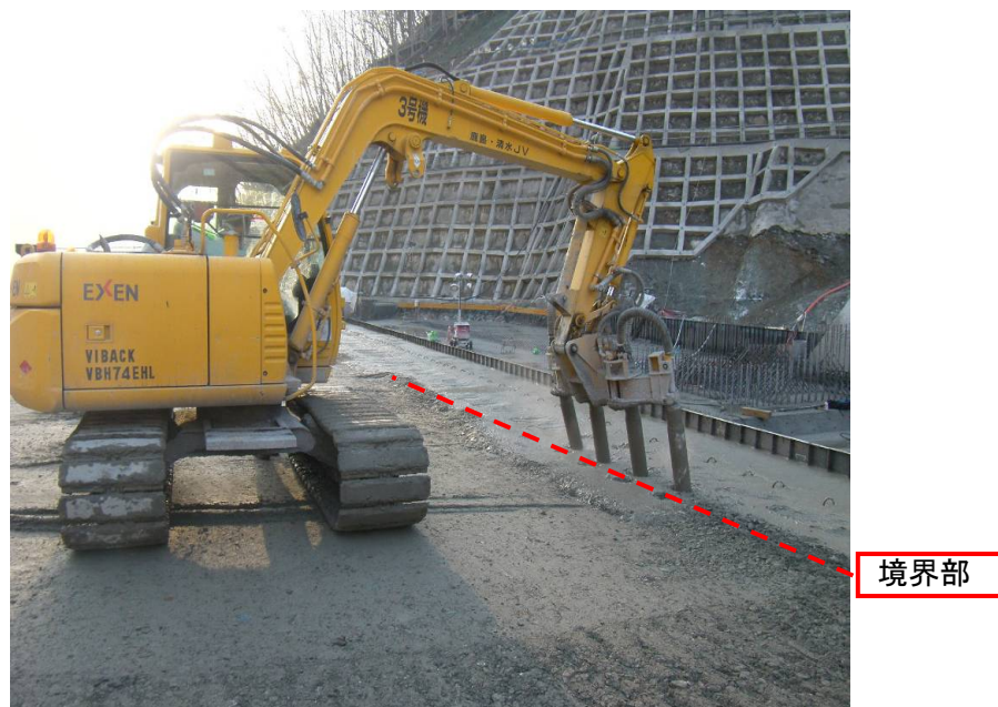
写真－3.3.14 境界部の内部振動機（バイバック）による締固め状況（湯西川ダム）
