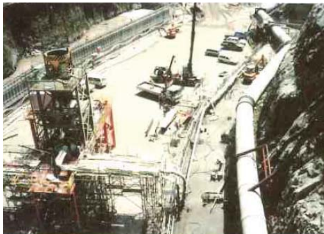
写真－2.4.7 PCD 工法による施工状況
