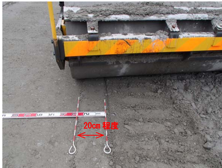
写真－3. 3. 10 振動ローラの転圧のラップ検測（五ヶ山ダム）
