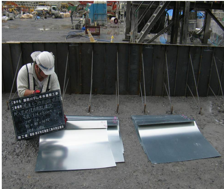
写真－3.3.6 亜鉛引鉄板（湯西川ダム）
