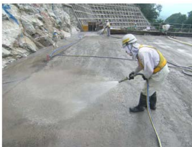
写真－3.4.7 内部コンクリートの打継面処理状況 1)
