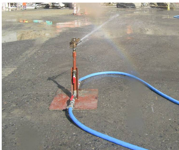
写真－3.3.16 スプリンクラーによる湿潤養生の一例（湯西川ダム）
