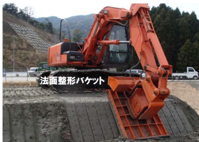
写真－2.11.6 FPC（プレート型端部法面締固め機）
