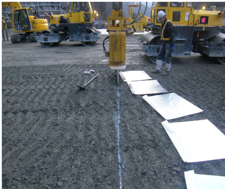
写真－3.3.7 目地切機で横継目の造成・亜鉛鉄板挿入状況（湯西川ダム）
