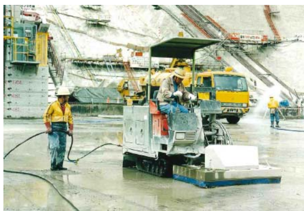
写真－2.4.5 自走式打継面処理機（KAME）
