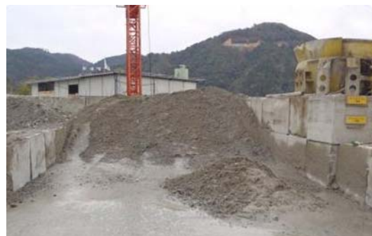
写真-2.10.8 グリーンカットずり仮置状況
