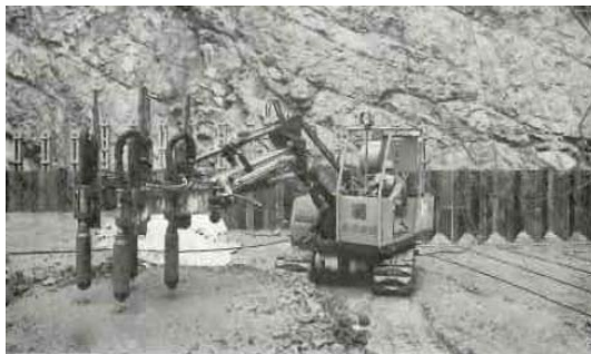
写真-2.2.4 油圧バイブレータ（四角配列）
