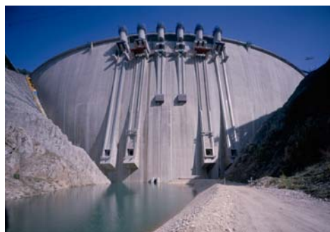
写真－3.2.4 アーチ式コンクリートダム （温井ダム）
