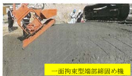
写真－3.4.3 二面拘束型および一面拘束型端部締固め機（FPC）
