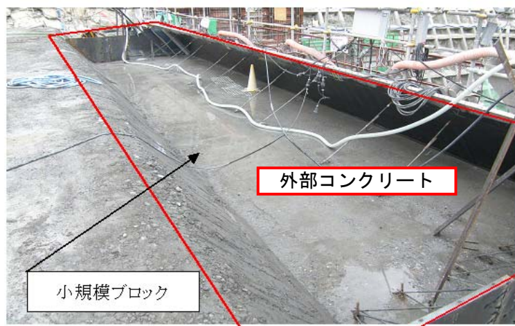
写真-3.4.2 最新のRCD工法（巡航RCD工法）における 外部コンクリート打設ブロック 1)
