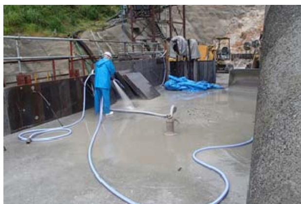
写真-3.4.6 外部コンクリートの打継面処理状況
