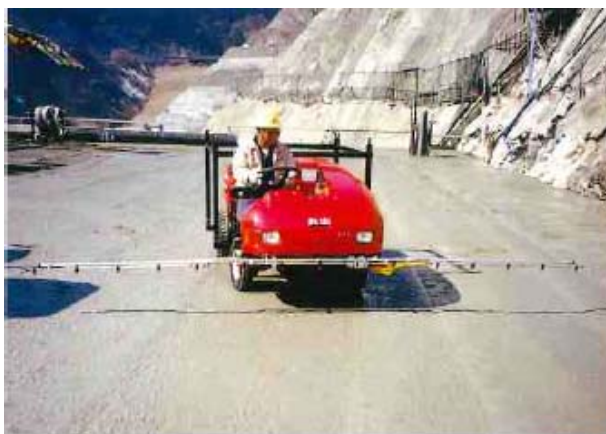
写真－2.4.6 遅延剤散布車による作業状況
