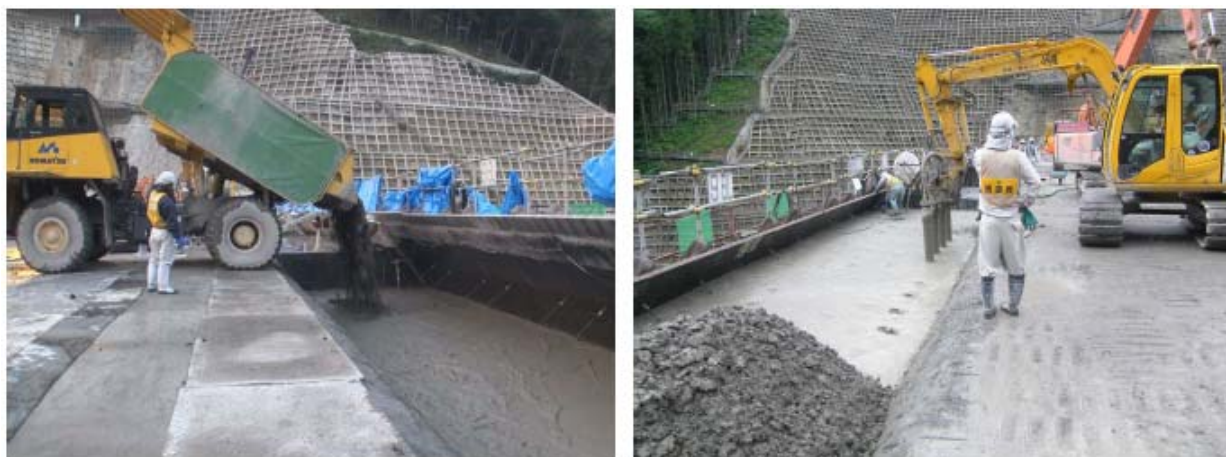
写真－3.4.4 外部コンクリートの施工状況 1)
