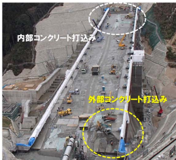
写真－2.11.4 最新の RCD 工法（巡航 RCD 工法）によるコンクリート打込み状況
