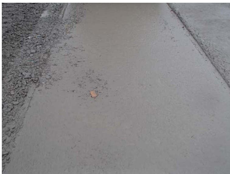
写真－3.3.12 仕上転圧後の転圧面の写真（五ヶ山ダム）
