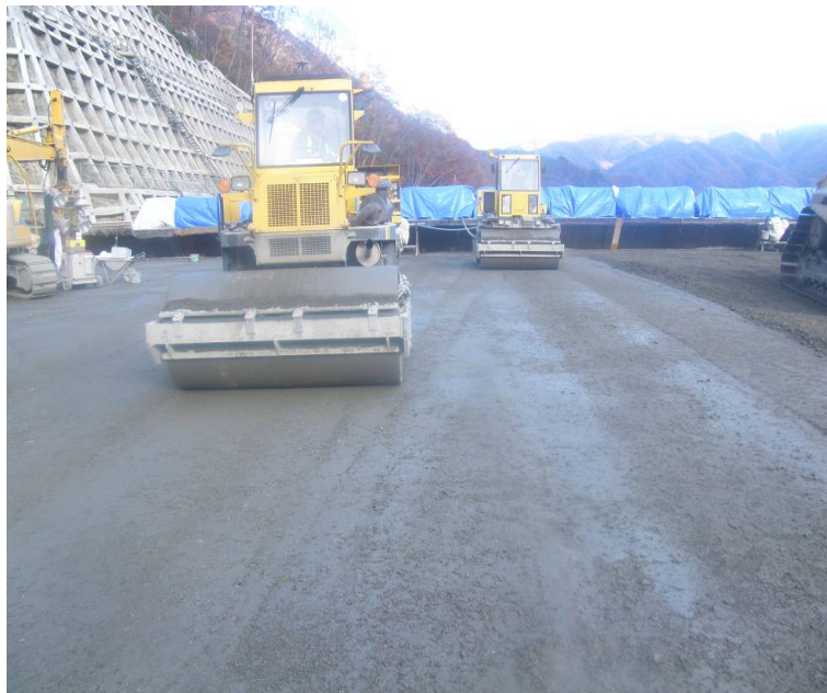
写真－3.3.8 振動ローラによる転圧状況（湯西川ダム）
