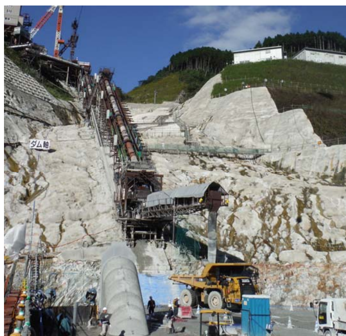
写真－4.4.10 40t ダンプトラックへのコンクリート供給状況
