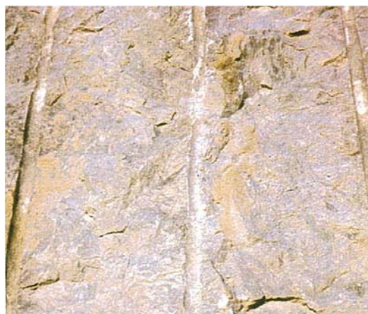
写真ー2.2.3 プレスプリット工法による岩盤面
