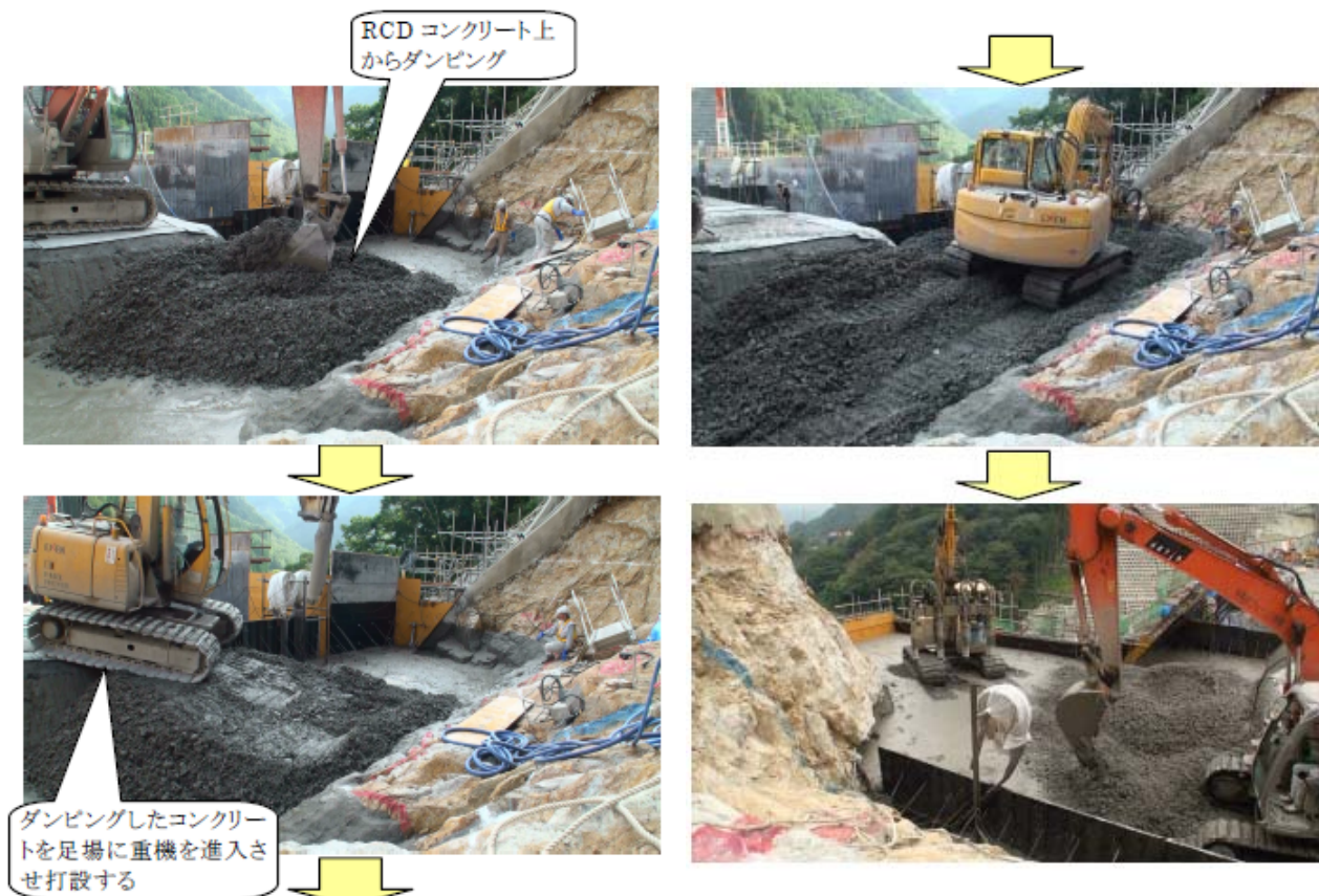
写真－3.4.8 着岩部有スランプコンクリートの打設状況 1)
