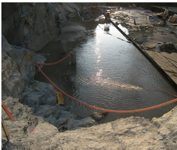
写真－3. 3. 18 外部コンクリート打継面の湛水養生の例（湯西川ダム）
