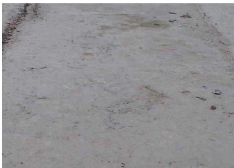
写真－3.3.9 振動ローラ転圧後の転圧面（五ヶ山ダム）
