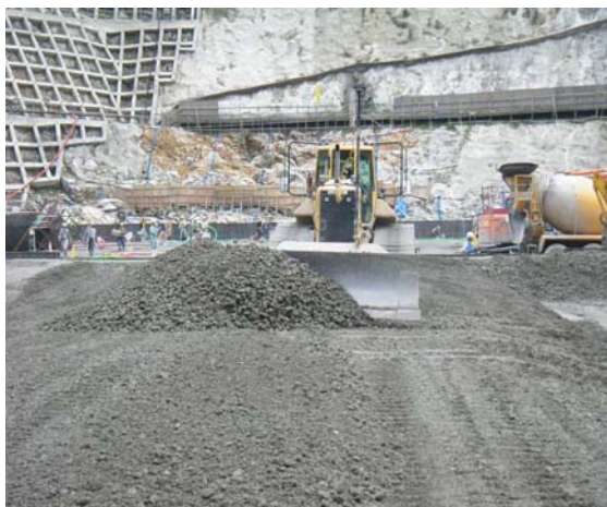
写真－3.3.4 RCD 用コンクリートの敷均し・締固めの状況（湯西川ダム）
