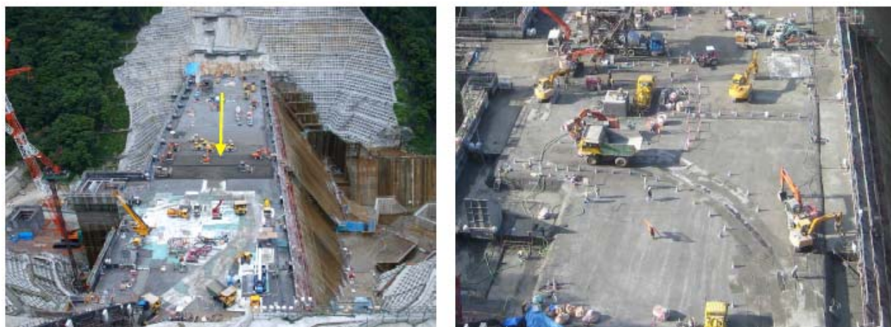
写真－3.4.1 最新の RCD 工法（巡航 RCD 工法）の施工状況 1)
