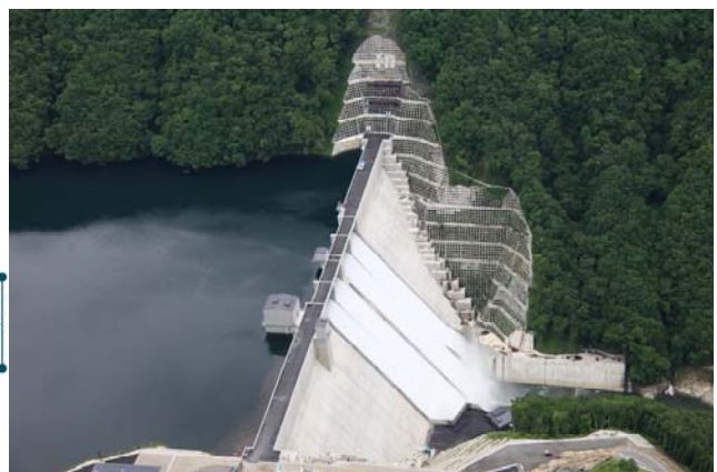
図－3.2.3 重力式コンクリートダムの断面例 写真－3.2.1 重力式コンクリートダム（湯西川ダム）
