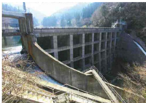
写真－3.2.3 バットレスダム（三滝ダム） 4)
