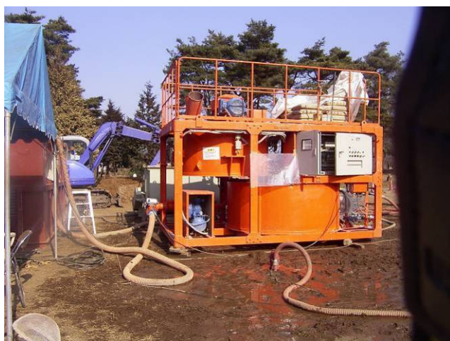
写真 2.2 プラント（左）と流動化処理（建設発生土と固化材の混合）の様子（右）
