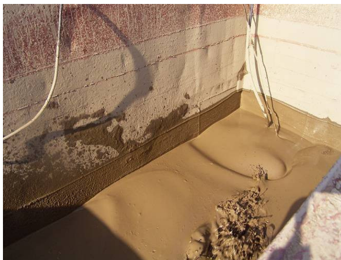
写真 2.1 泥水タンク内で加水，解泥された建設発生土
