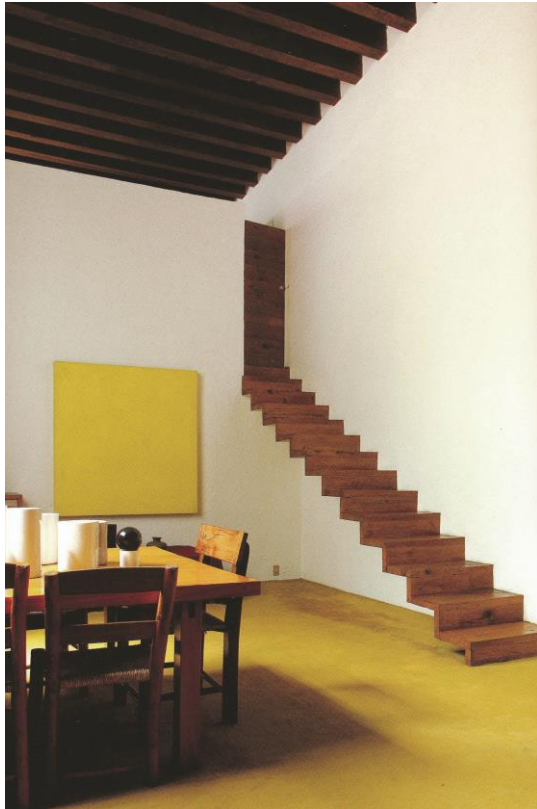
図 7-36 バラガン自邸 木の厚板の片持梁の階段
