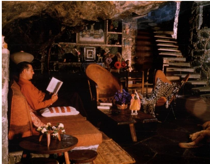
図 8-25 オゴルマン自邸 片持梁の階段
