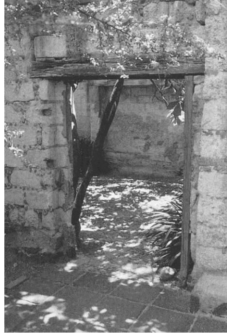
図 7-24 オルテガ邸 組積造の門
