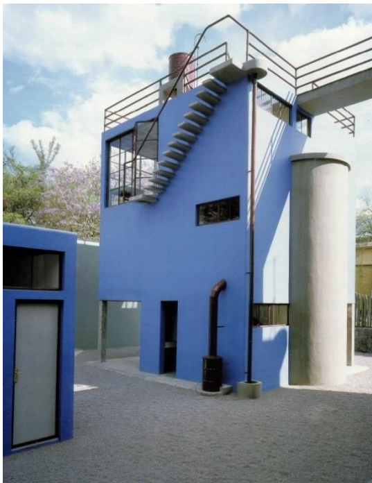
図 4-14 カーロとリベラの家 カーロ棟 外観
