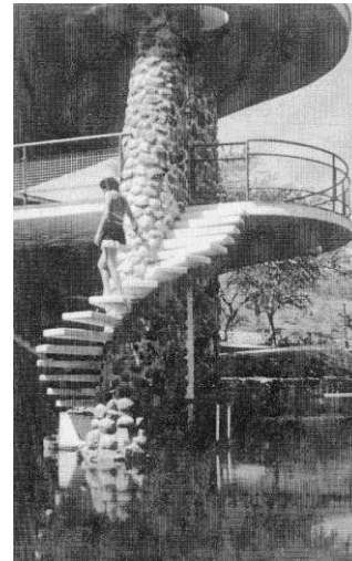
図 6-28 キンターナ邸 片持梁の階段
