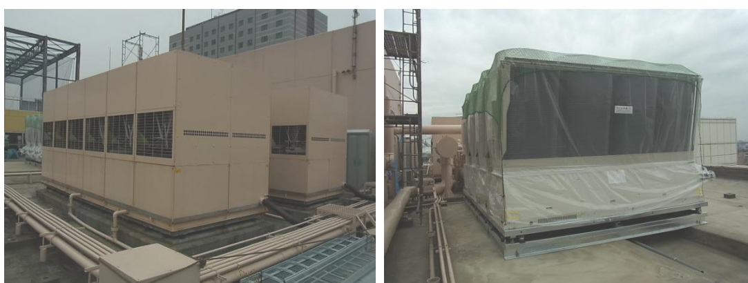
写 3-3 改修前後のヒートポンプチラー(左:改修前、右:改修後)
