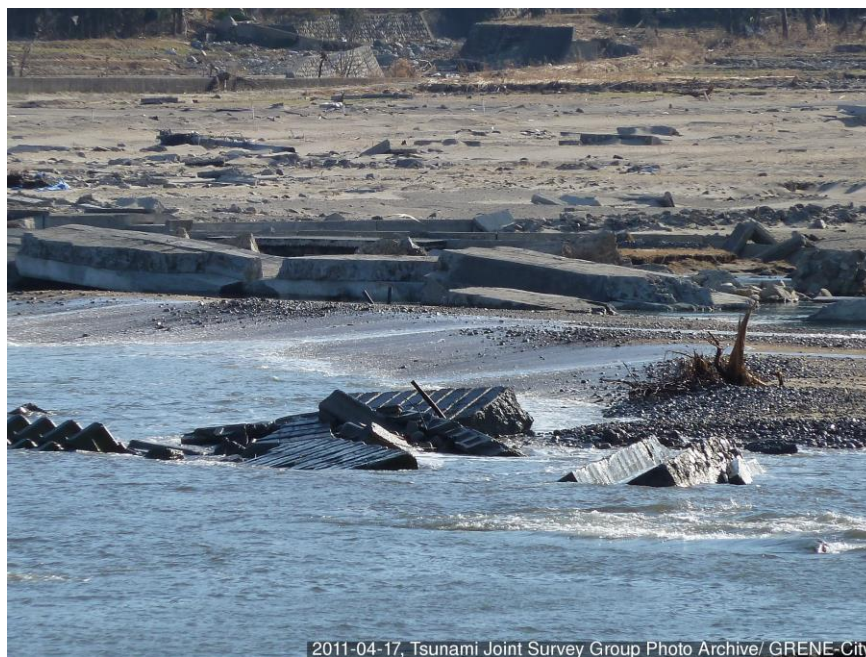
写真 4-1 吉浜湾における被災状況
