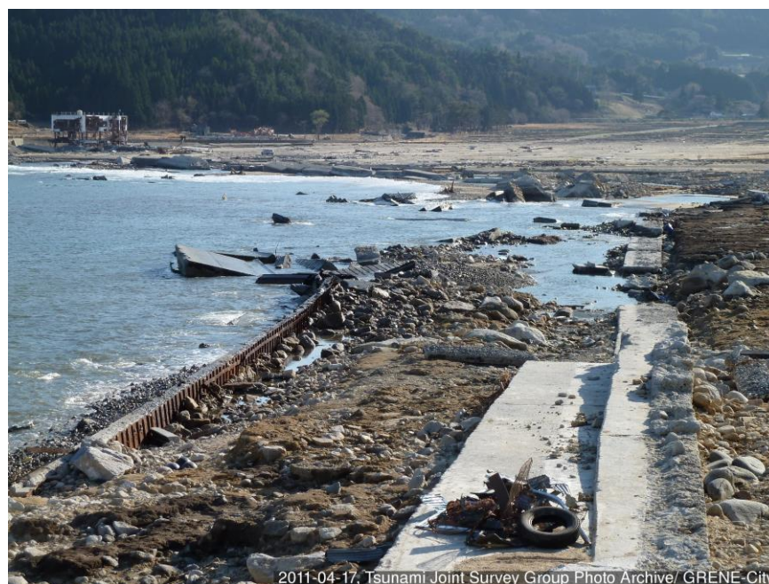
写真 4-2 吉浜湾における被災状況
