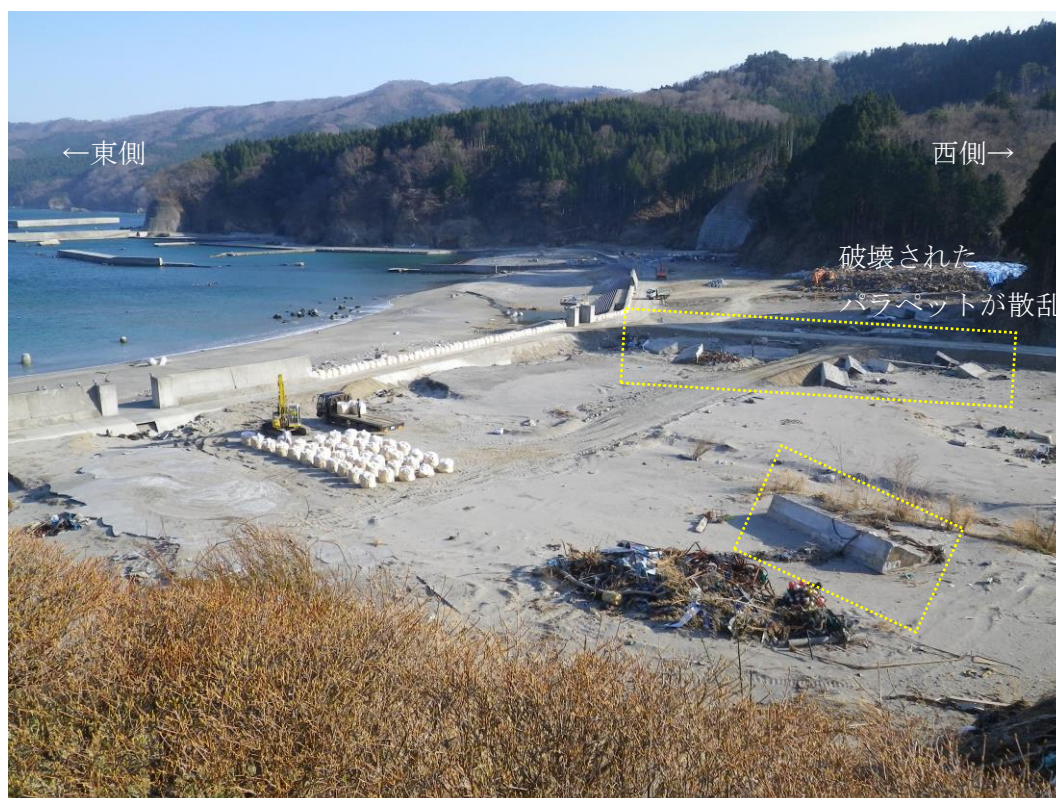
写真 3-4 綾里湾白浜海岸南側の堤防破壊状況(2011 年 4 月撮影)
