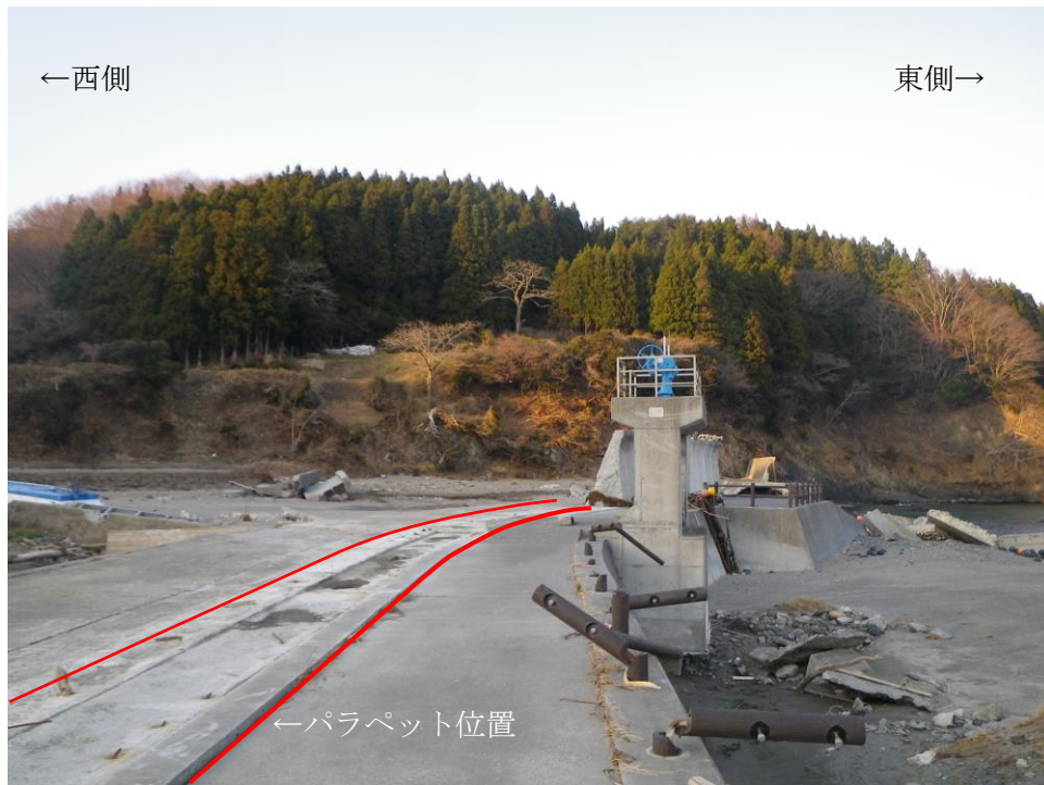
写真 3-2 綾里湾白浜海岸北側の堤防断面(2011 年 4 月撮影)
