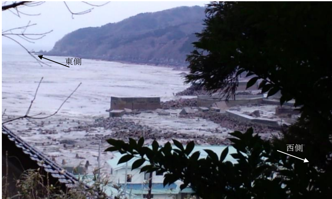
写真 3-7 津波により野野前漁港及び防波堤が破壊された様子 (2011年3月11日15時40分ごろ)
