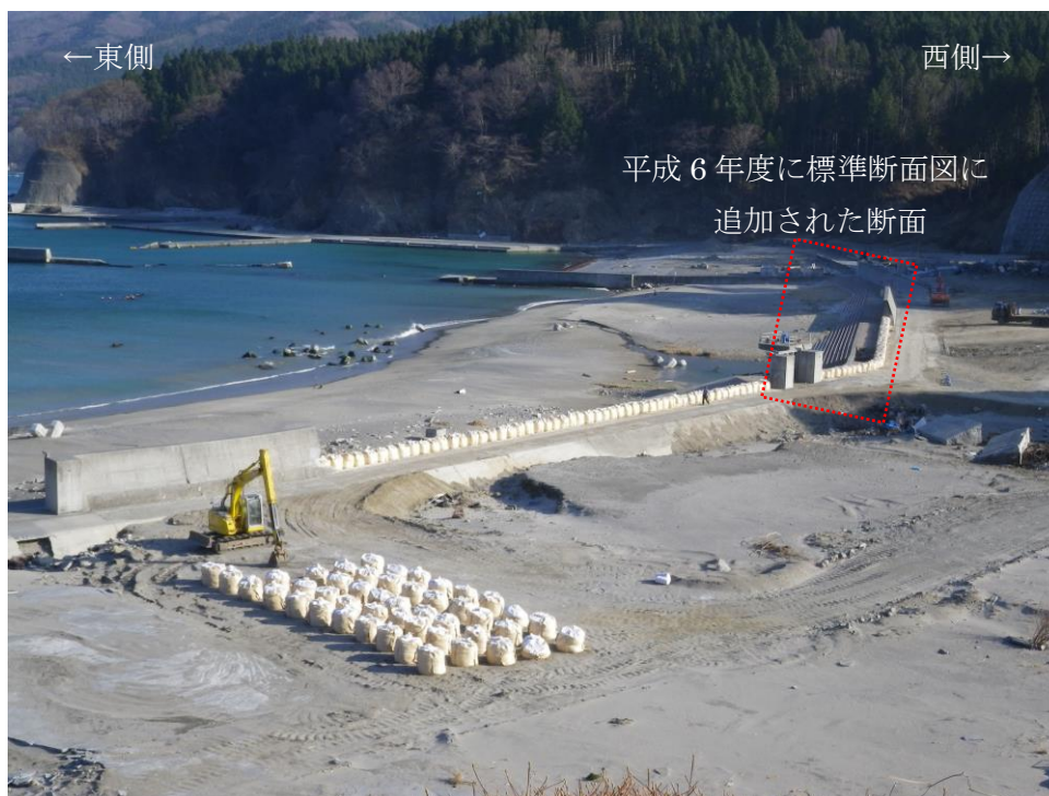
写真 3-3 綾里湾白浜海岸南側の堤防断面(2011 年 4 月撮影)
