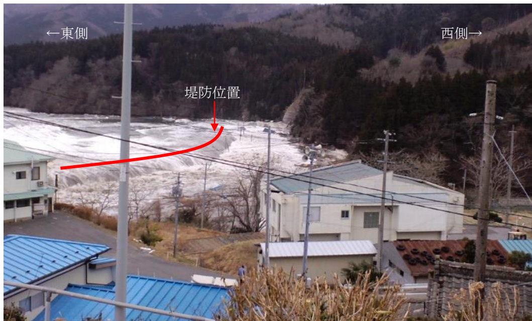
写真 3-6 第一波目の津波が堤防を越流する様子 (2011年3月11日15時19分ごろ)
