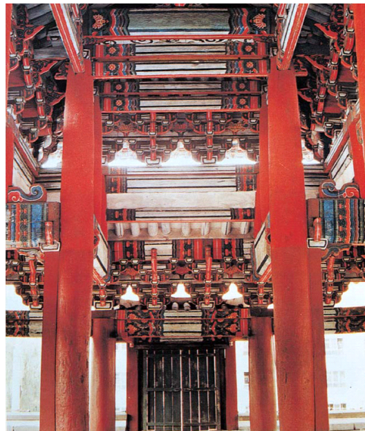
図 7-18 平壤普通門の内部梁架構 (『北韓文化財解説朱集Ⅲ(一般建築編)』、p.80より)
