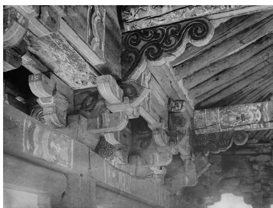
図 7-4 安邊客舎駕鶴樓の桁行方向の梁 （『朝鮮古蹟図譜11』、p.1567より）
