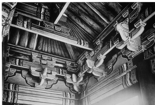
図 7-2 永興濬源殿正殿の内部 （『朝鮮古蹟図譜11』、p.1529より）
