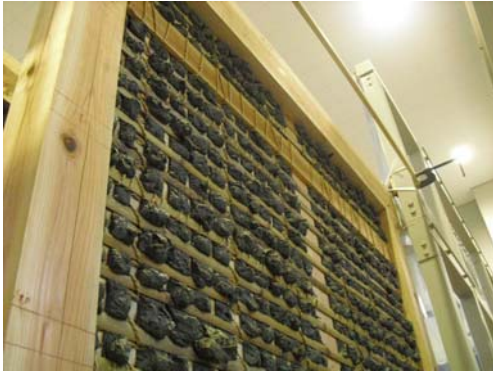
(7) 片側荒壁塗り完了後の裏側
