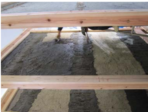
(9) 中塗りと貫伏せ同時施工
