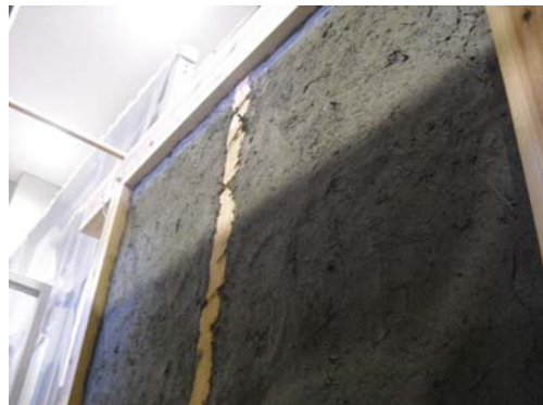
(6) 荒壁塗り完了
