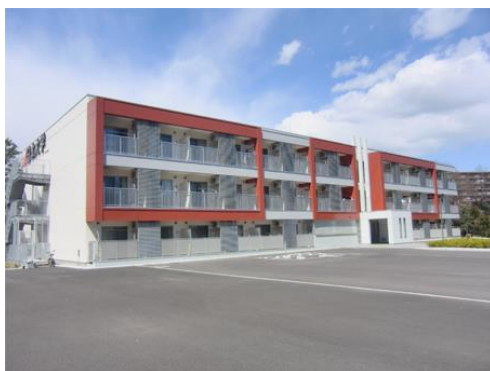
図 3-6 竣工後の学生寮
