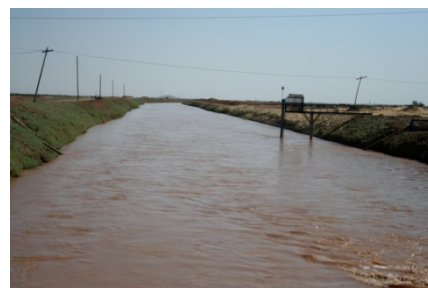
(h) 幹線排水路
