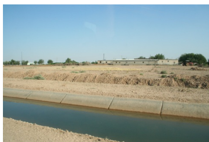
(a) 幹線水路
