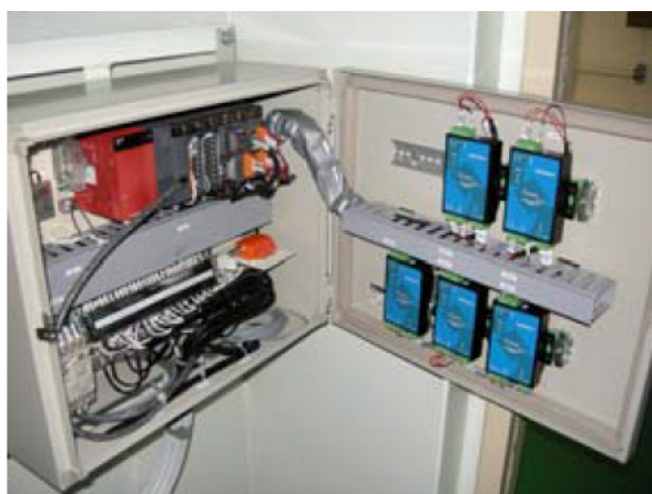
図 1-6 船上に搭載された SIMS の計測装置[8]
