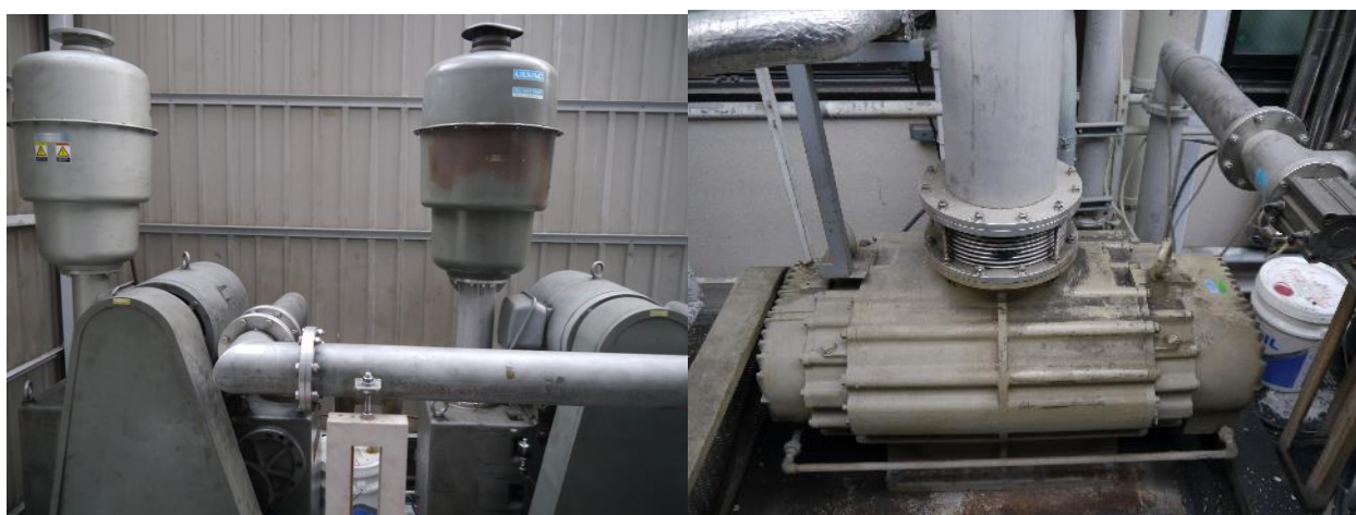
図 22 (左) ロータリーポンプ, (右) メカニカルブースターポンプ
