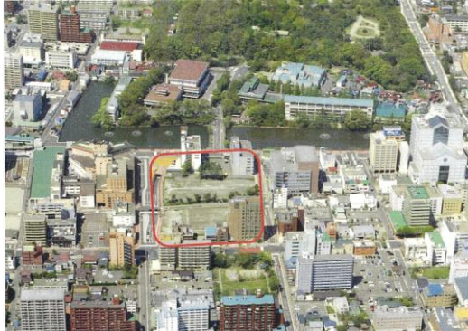
図 4.27 着工前の様子 15)
