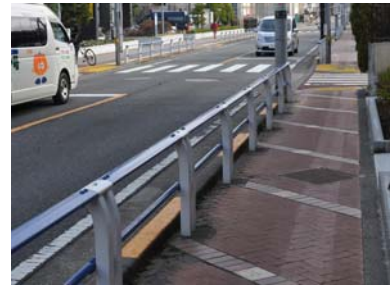
図 5-35 電柱・ガードレールの一体化と白線標示
