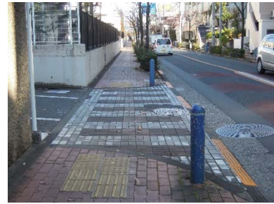
図 5-37 歩道段差の解消と 点字ブロックの設置
