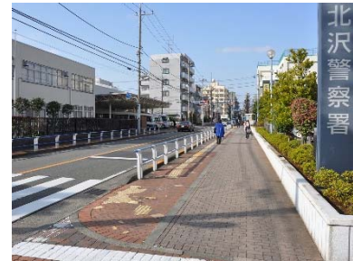
図 5-33 車道かさ上げによる セミフラット構造
