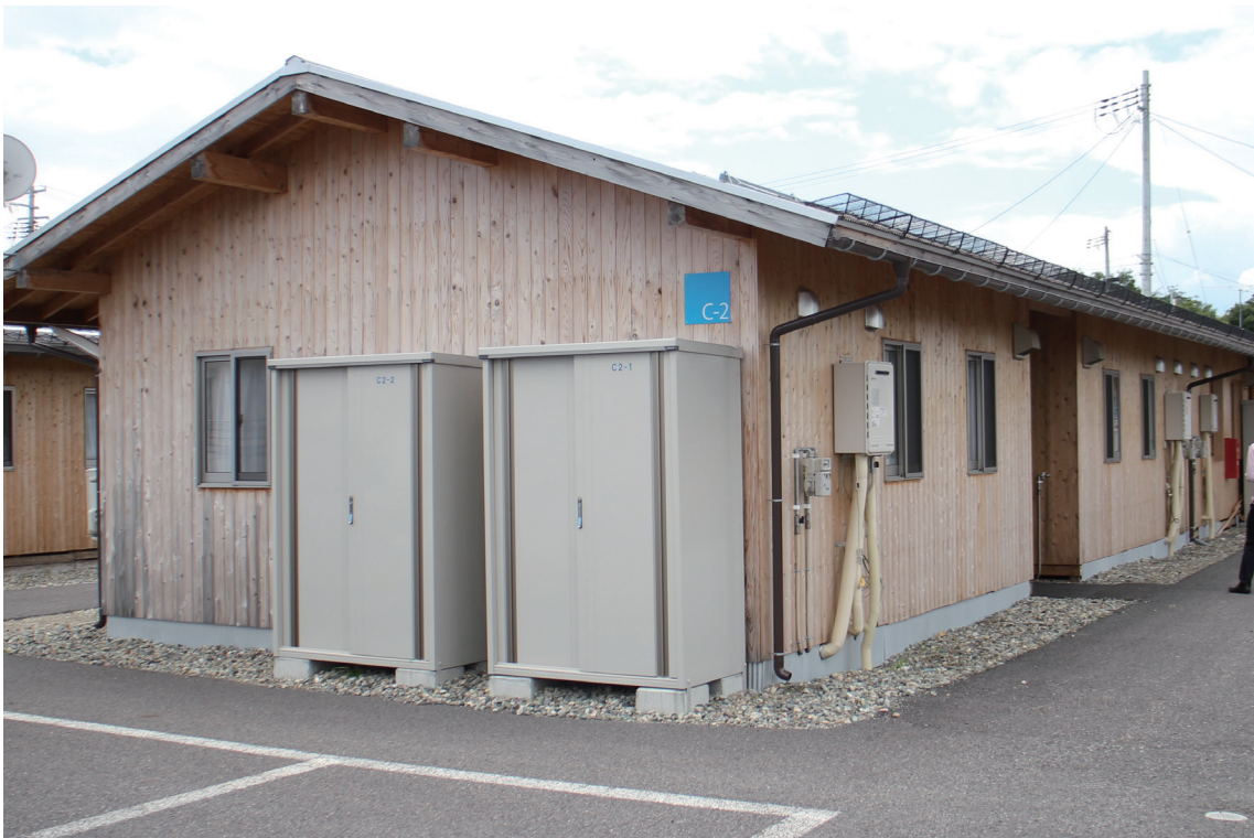
図5-11. 木造の応急仮設住宅 (写真は公募による地元業者が建設した住宅)
