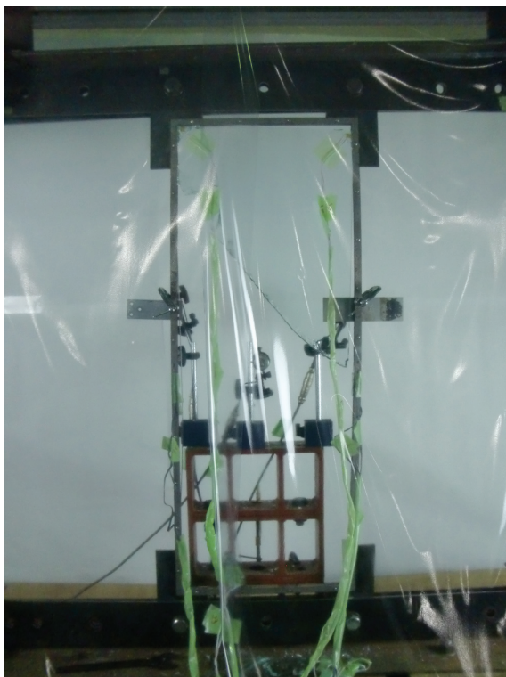
図 33: 試験体 101(B14) 損傷写真
