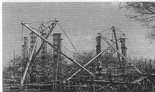
図12 張力導入後の2基の3-strut張力システム
