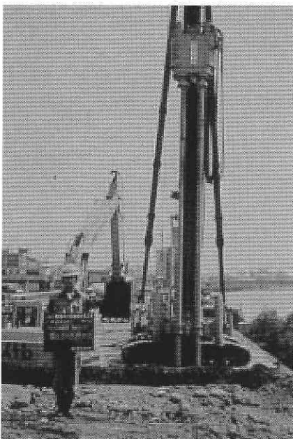
写真1 信濃川堤防における深層混合処理工法の施工
