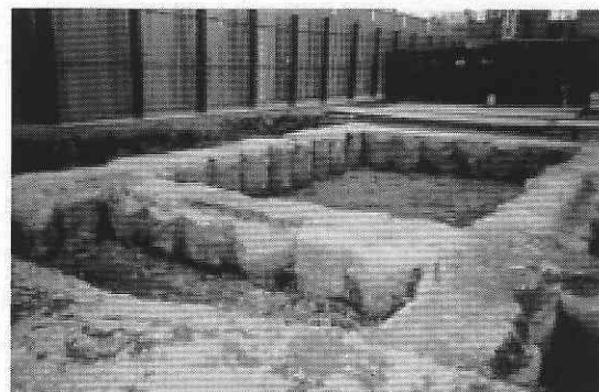
写真3 格子状のセメント改良地盤の例
