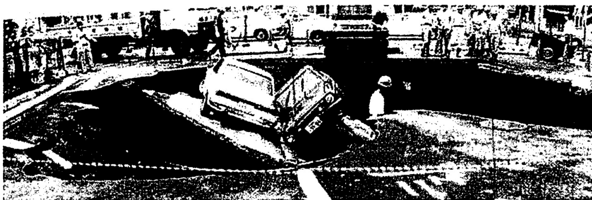
写真4.1 下水管渠に起因する道路陥没事故（名古屋市上下水道局提供）
