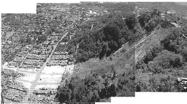
図1 Las Colinasの斜面崩壊(2001)
